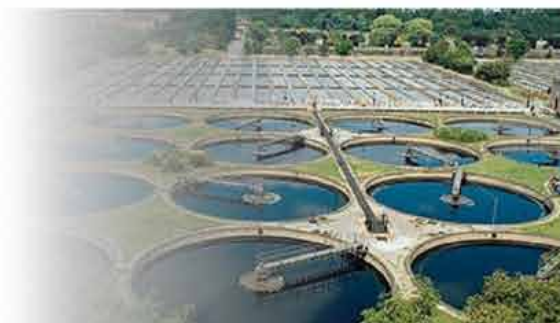
Noticias sobre Aguas Residuales
