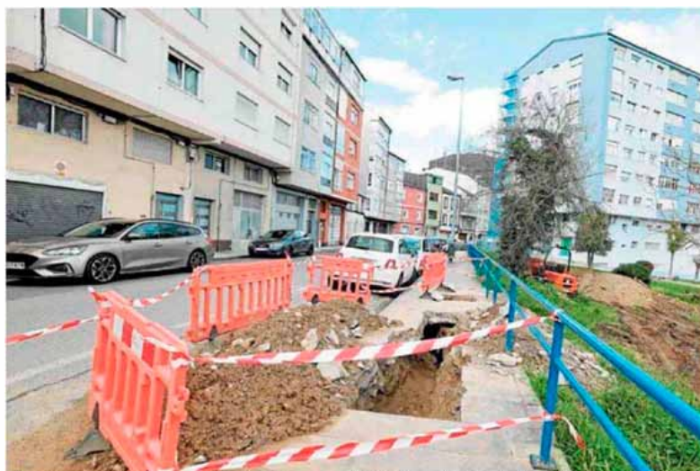
Obras de reparación de una avería en la red de agua en la Rúa Alexandre Bóveda el pasado febrero. SEBAS SENANDE
