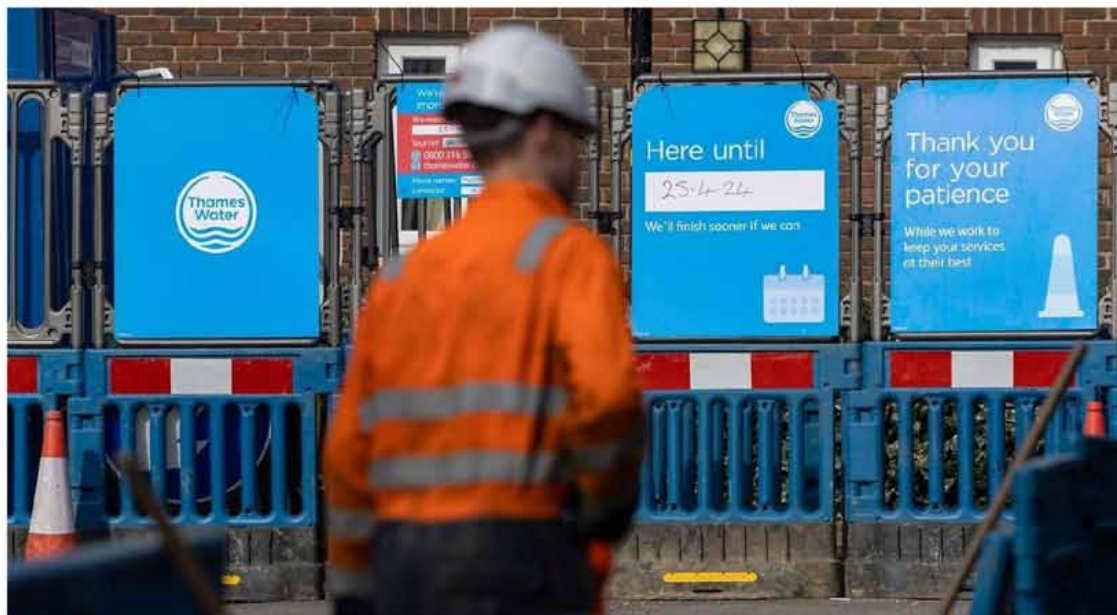
Un operario de Thames Water en unas obras. Foto: Bloomberg
