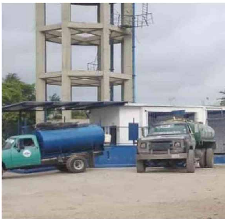
Los conductores se tomaron las instalaciones del tanque de agua en Loma Fresca y la alberca de San José.
